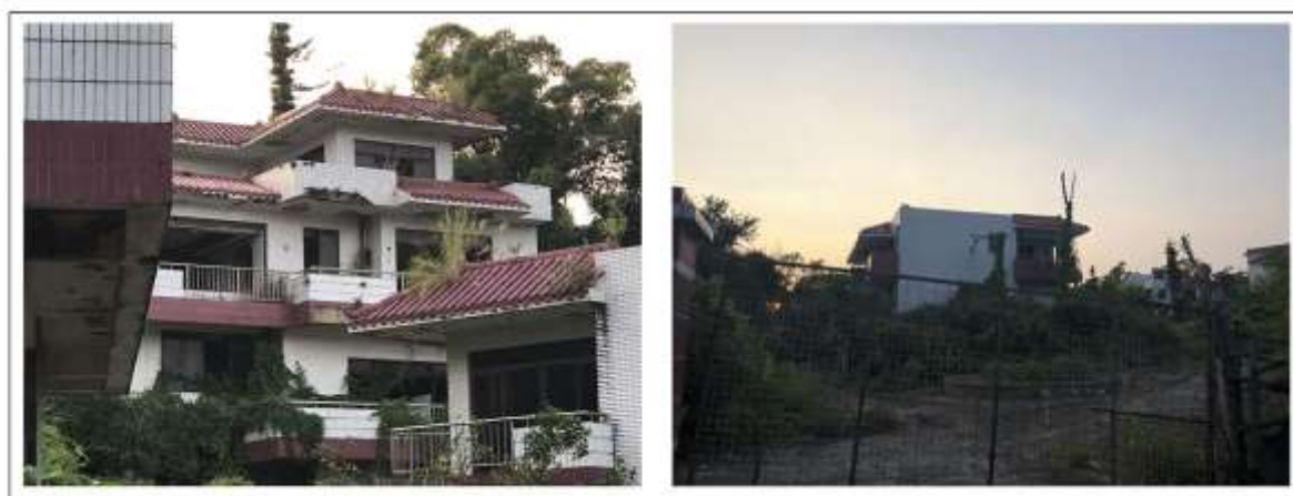
图 6-5-2 机场南侧现状房屋照片
